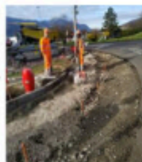
Deux opérateurs procèdent au changement et déplacement de bordures en béton, permettant de gagner près de 1 mètre sur la largeur de la voie. Photo Le DL/D.N.
